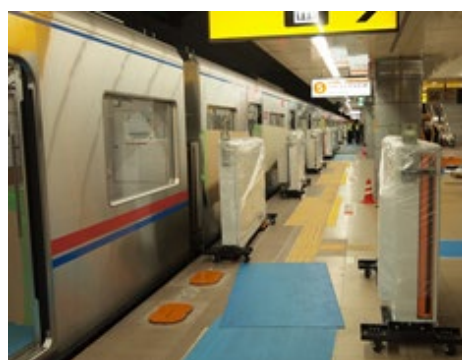
成田空港駅 5 番線ホームドア設置風景
