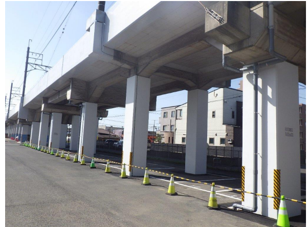
千原線高架橋耐震補強工事
