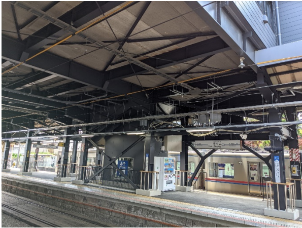
耐震補強工事が完了した東中山駅
